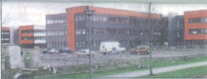
● Le parc de la Haute-Borne est encore en pleine construction.
