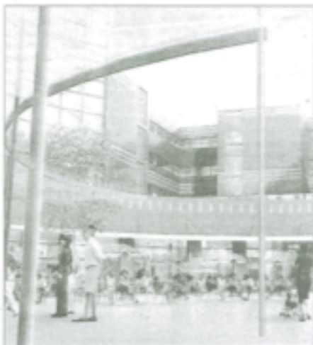
Une grande partie du projet est articulée autour de la place centrale, orientée plein sud et dédiée à 12 des 15 restaurants.
