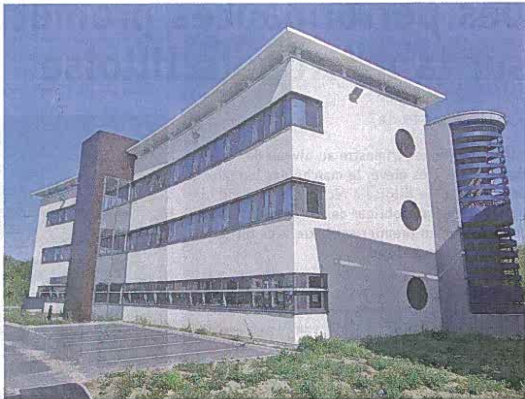
Arc distribution, filiale du groupe Arc international, s'est implantée sur 1 700 m 2 sur le site Château-Blanc à Wasquehal (Promoteur Bouygues immobilier, commercialisateur Tostain&Laffineur).
